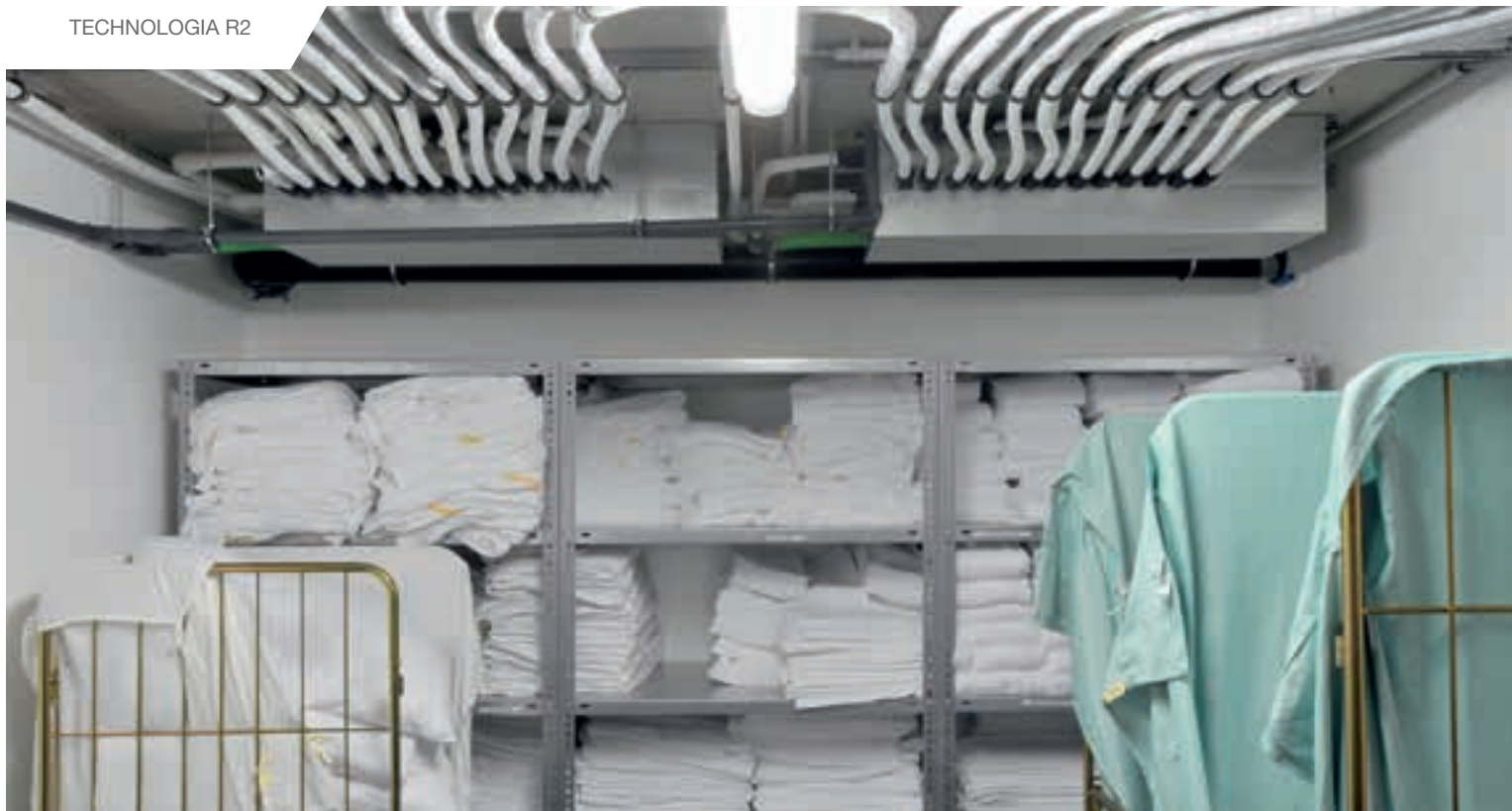
Nie zabierają miejsca: Kontrolery BC do dopasowanego do potrzeb rozdzielania energii zostały zamontowane pod sufitem w pralni.
